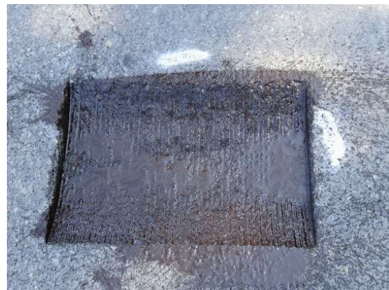
(d) Tack Coat Applied on a Grooved Pothole Surface
