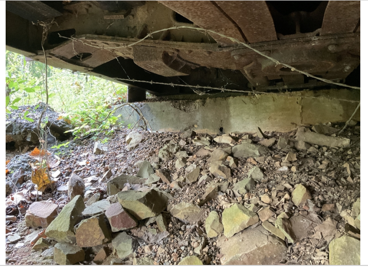
Bent 2 spall
