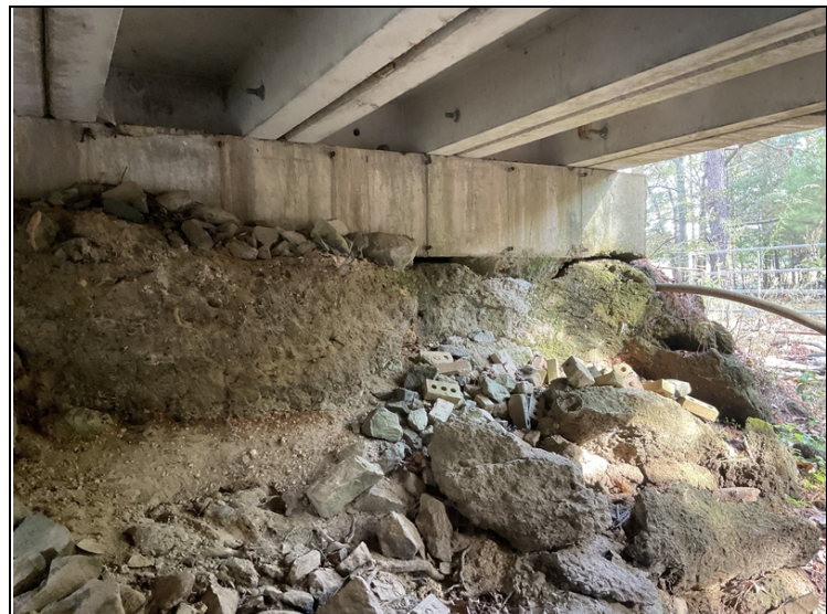
Bent 1 left erosion .
