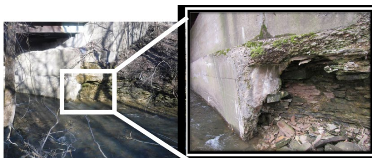
Figure 18. Non Scour Resistant Rock
