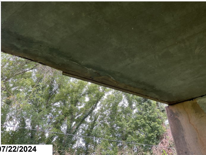
Spans 4 - 9: Delam. 86SF CS2
