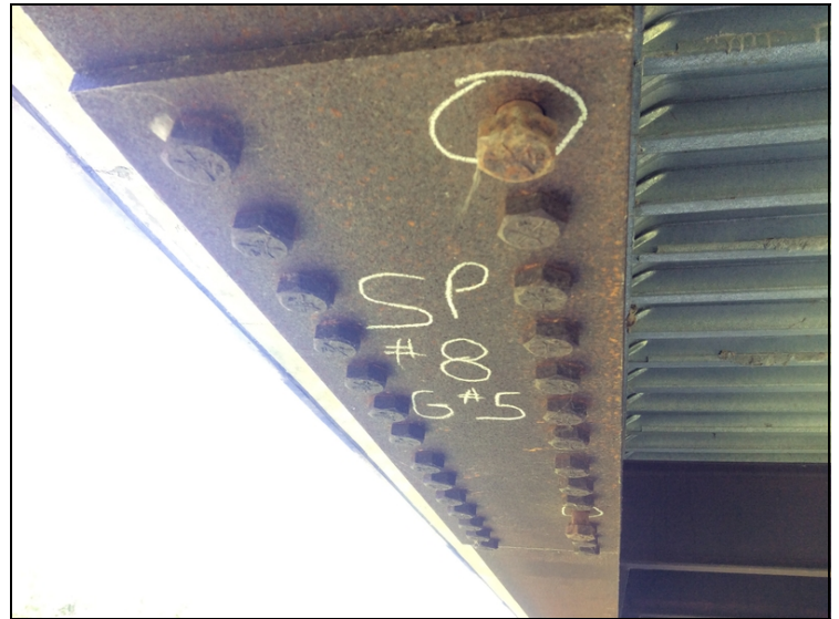
Span #8, girder #5-Loose bolt.
