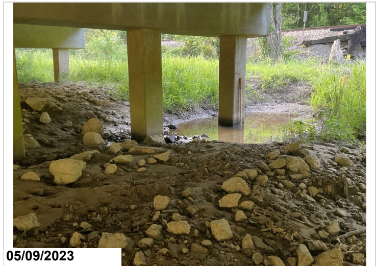
Bent 4 pile 6 local scour
