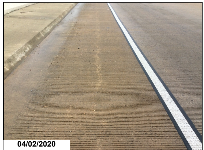
Span 1 longitude cracks.
