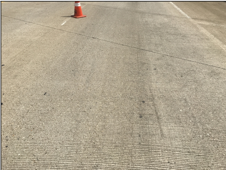
Span 5 longitude crack.
