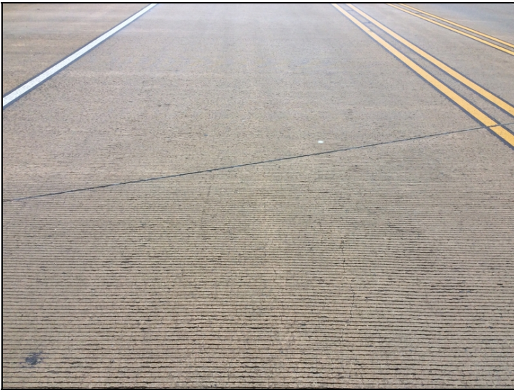
Span 1 longitude cracks.
