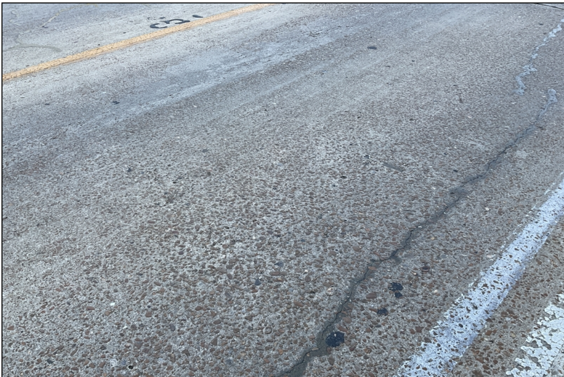
Span 1 abrasion
