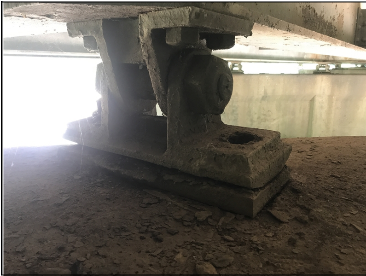
Missing anchor bolt.
