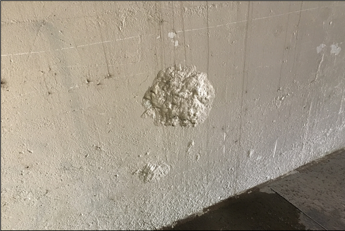
Bent 1 spall
