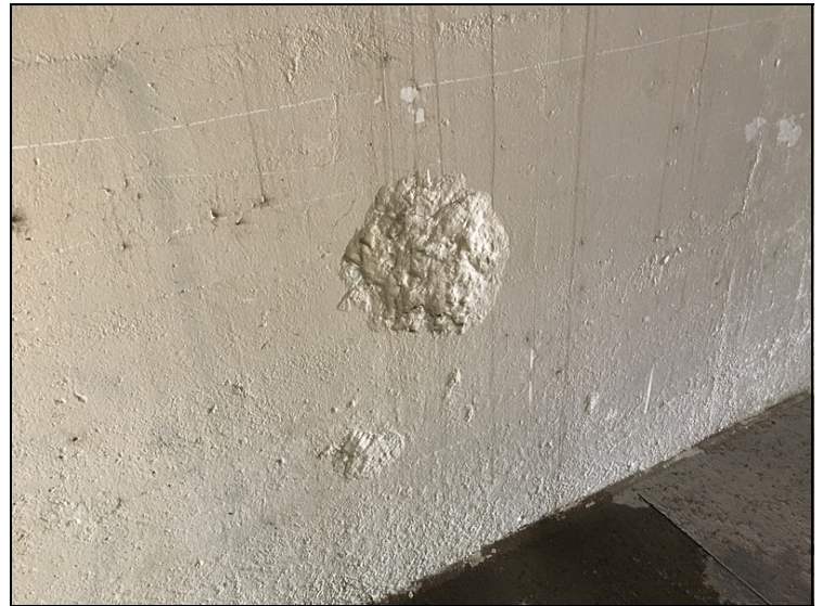
Bent 1 spall
