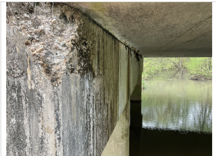
Bent 2 spall
