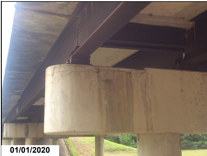
Cap - Bent 2 left : Delamination
