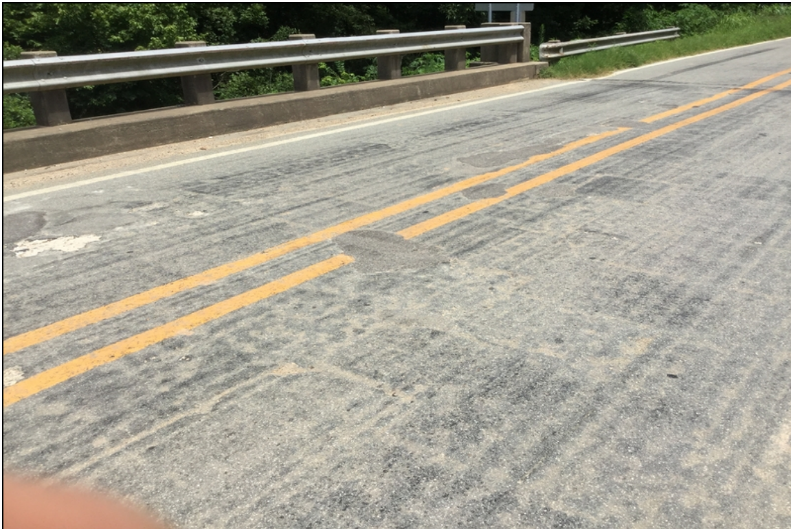
Span7 Cs3 spalling
