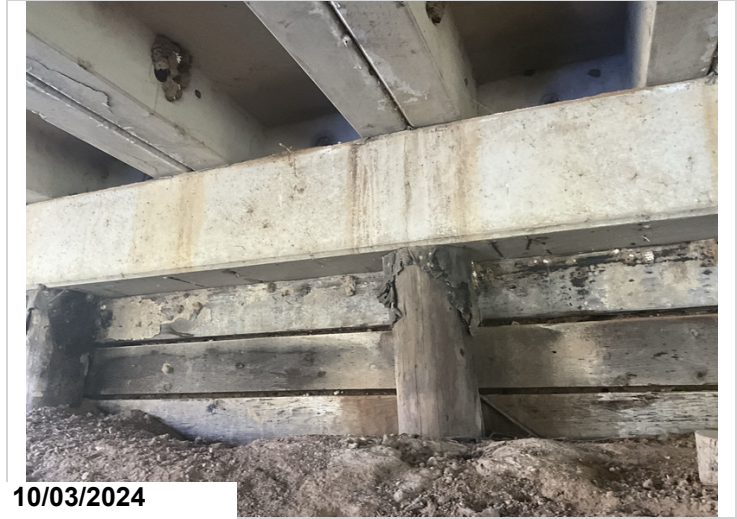
Bent 1, bottom 10' rebar. Cs3.
