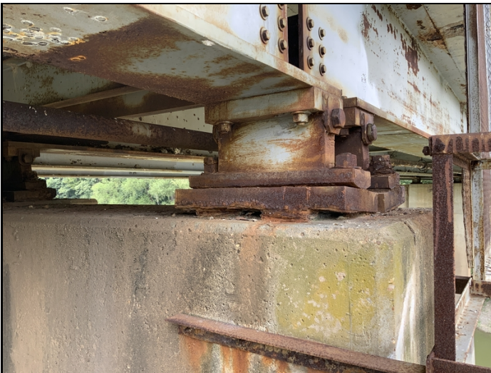
Bent #9 bearings .
