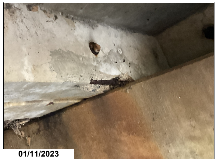
Span 4 unit 4 rebar CS3
