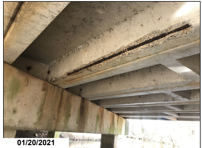
Span 3 unit 6 rebar CS3
