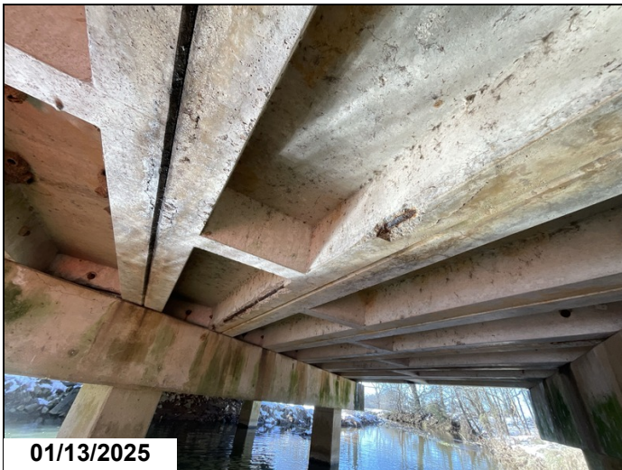
Span 3 unit 6 rebar CS3
