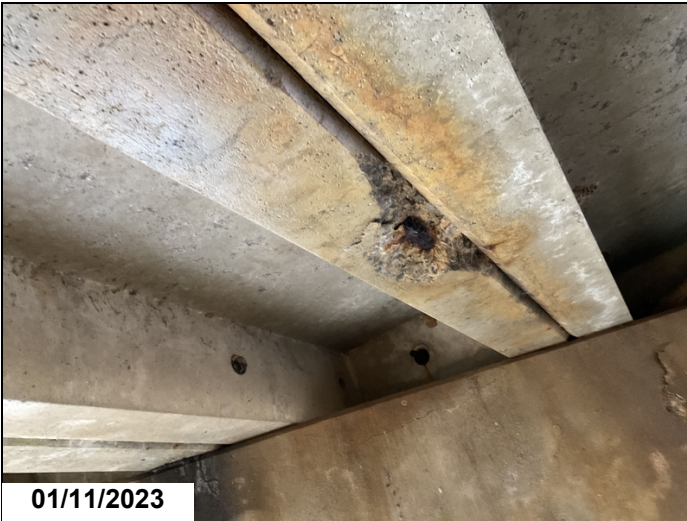
Span 4 unit 6 rebar CS3
