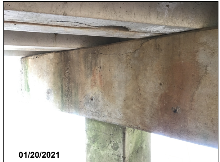
typ cap cracks/delam CS3
