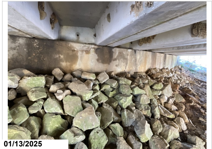
Bent 1 crack/delam CS3
