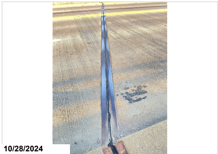
Bent 6 1/2 torn/ adhesion 2
