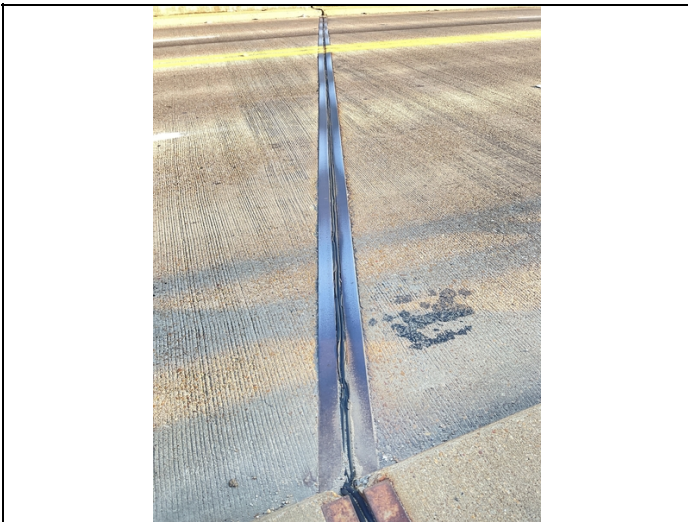
Bent 6 1/2 torn/ adhesion 2
