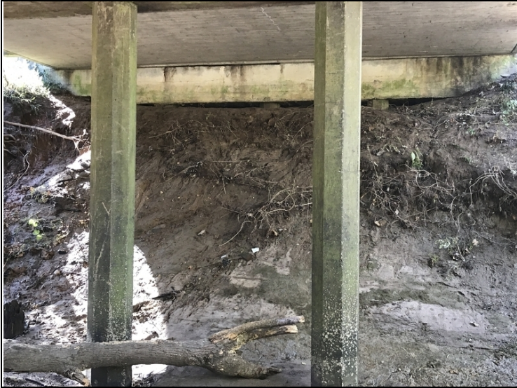
Bent 4 erosion
