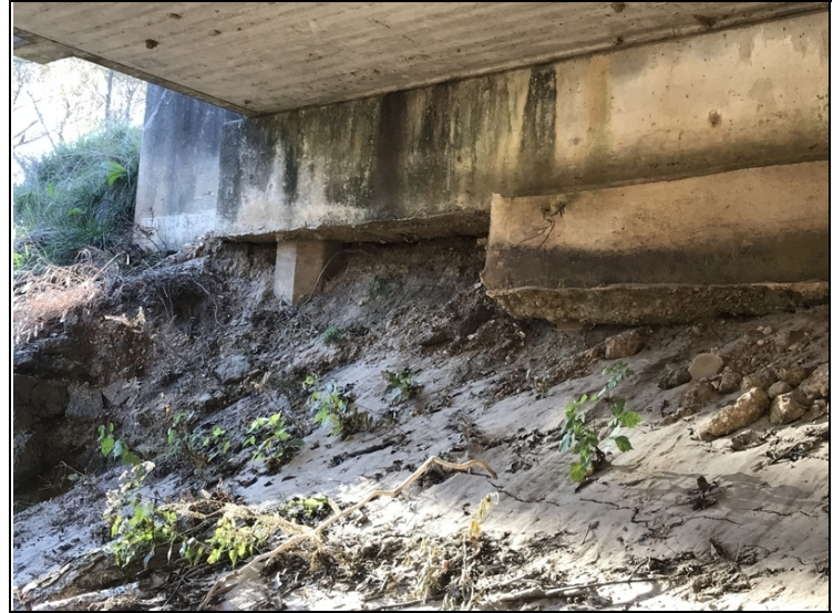
Bent 4 erosion
