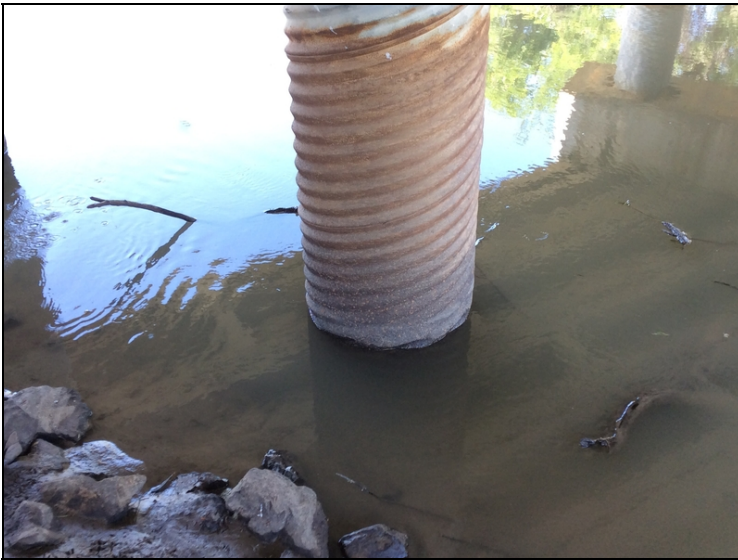
Bent 2 pile 2 pile encasement.
