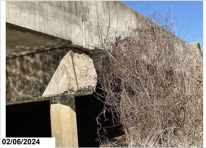
Bent #5 cap right end
