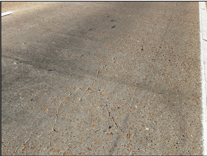
typ cracks
