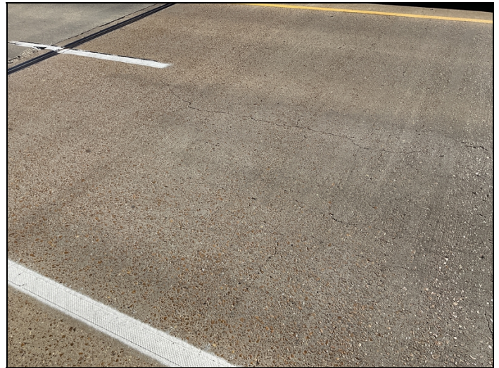
typ deck cracks
