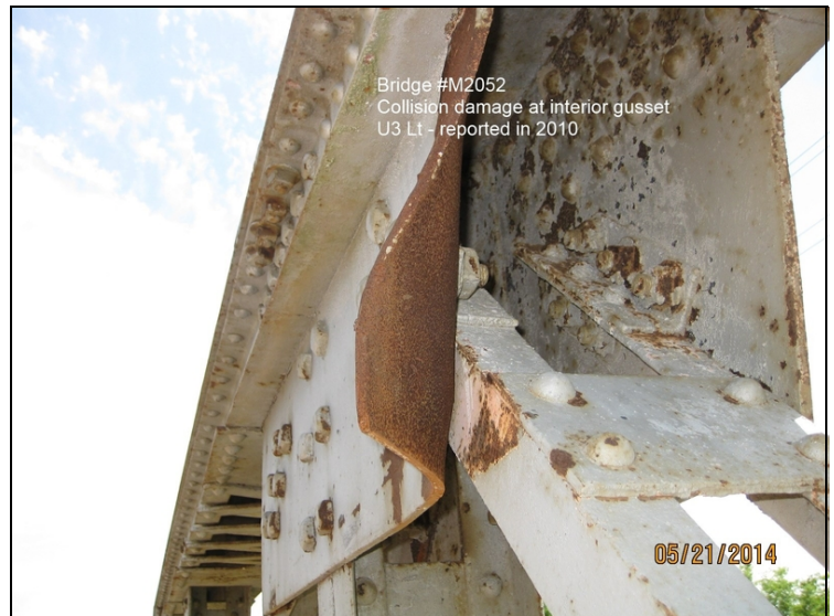
M2052 Gusset Plate U3 Lt. side 05-21-2014 - old damage
