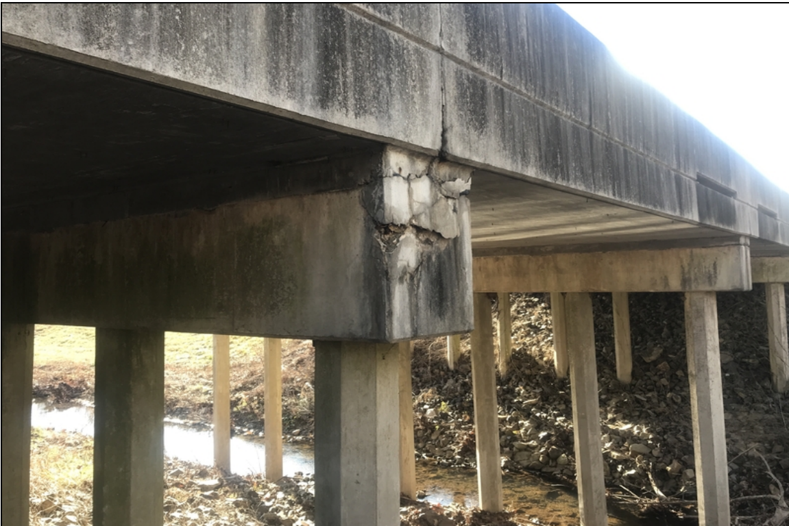
Bent 4 cap right side delam.
