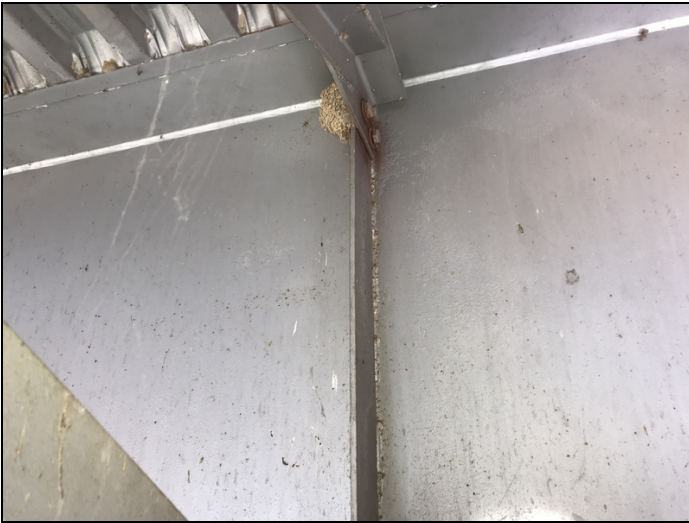
Span 5 g2 dia 4 loose bolts
