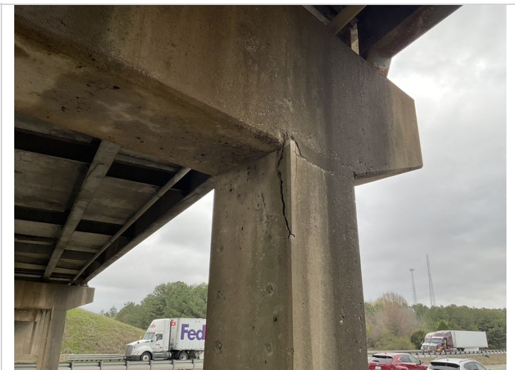
Delam bent 2 column 2
