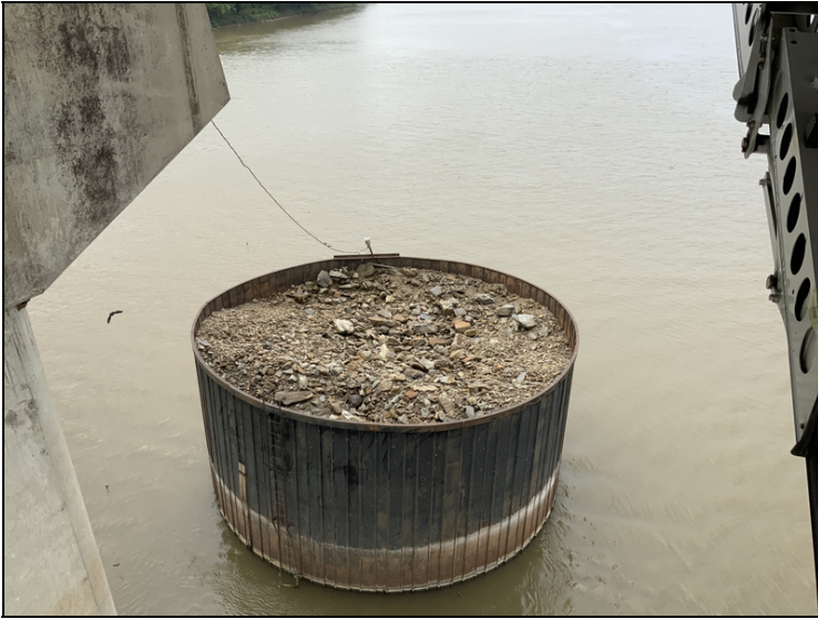
Pier protector missing fill material.
