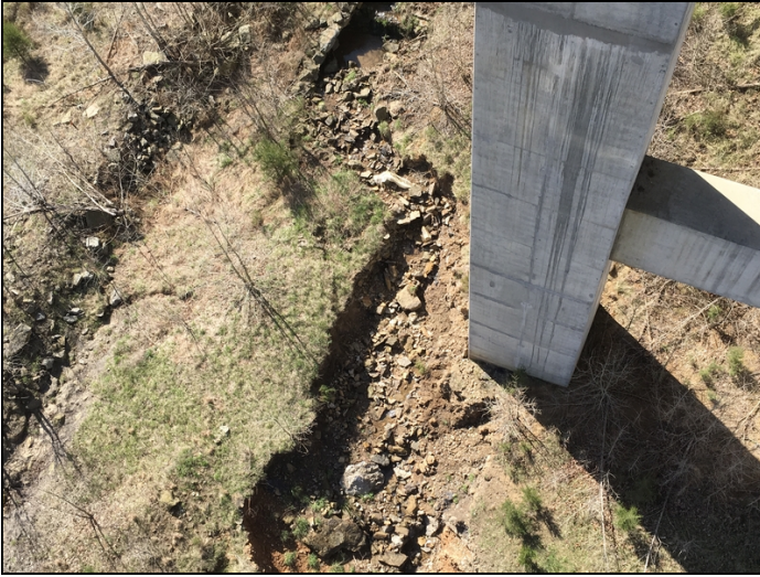
Bent 3 erosion .
