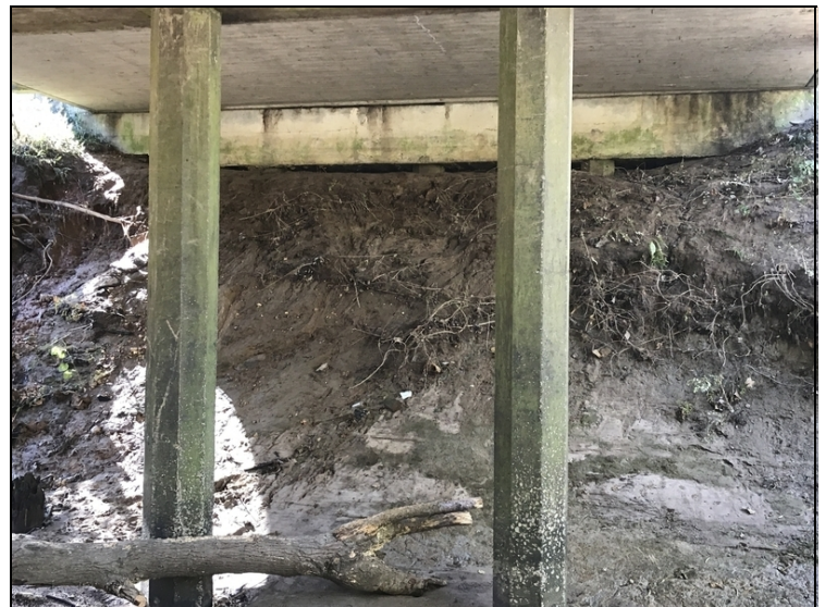
Bent 4 erosion
